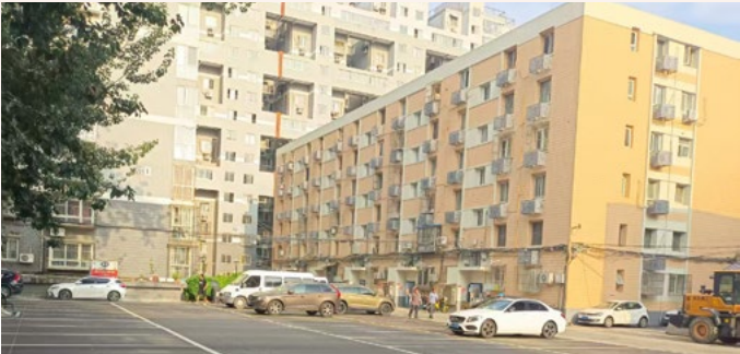
集团实施路面整体硬化改造
